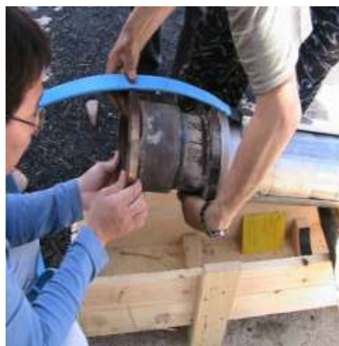
Дээд эх үүсвэрийн гүний худгийн насосыг шинэчилж байгаа нь
